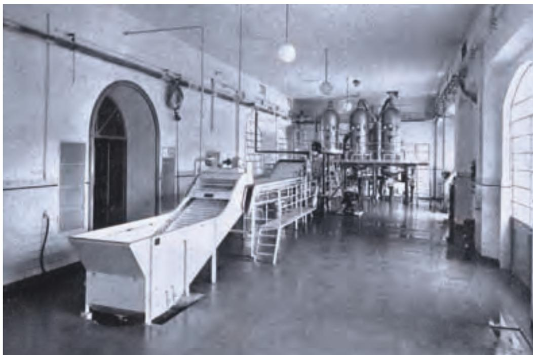
*La fabbrica della Stazione Sperimentale, in linea con le normative internazionali dell'epoca, si dota di una linea di lavorazione e concentrazione del pomodoro completamente realizzata in acciaio inox (in sostituzione del rame). Qui una immagine della linea di lavaggio e cernita e i concentratori al fondo in uno scatto del 1956 (Archivio SSICA).*
